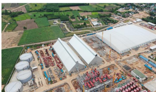
泰国 KSP 糖厂及发电厂建设项目（日处理甘蔗 24000 吨）（EPC 总承包方为广西建工集团第一安装有限公司）
