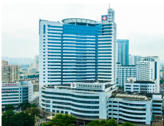
广西区人民医院门诊综合楼 (2005 年度部级优秀勘察设计三等奖)
