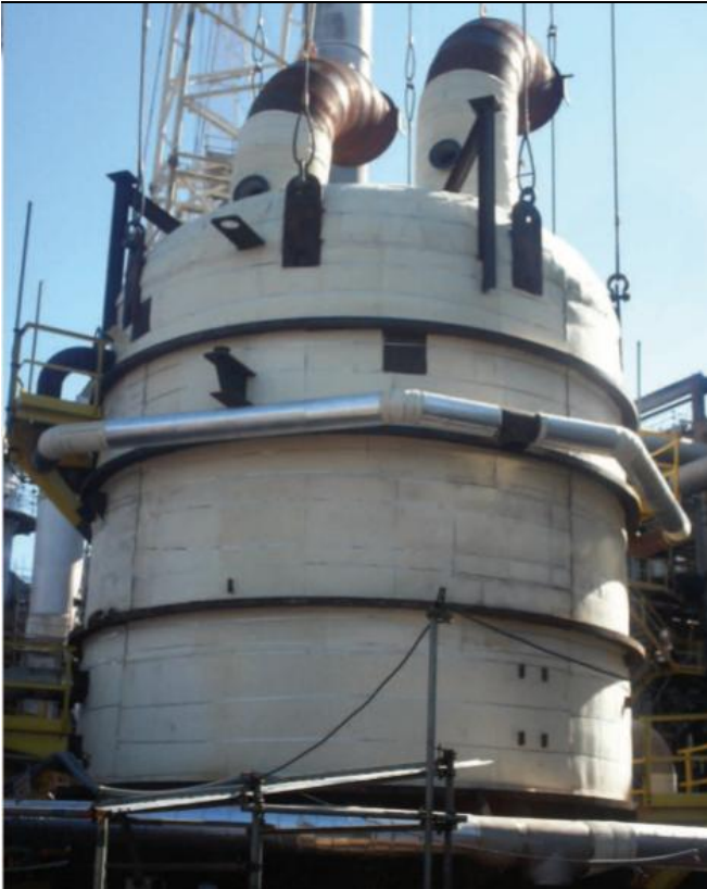
图 12: 蒸馏塔气凝胶外保温材料
