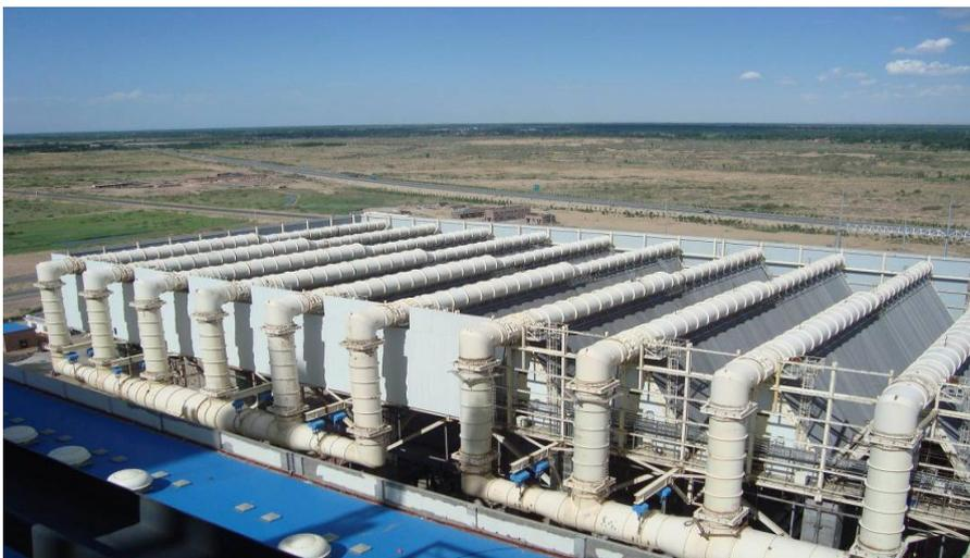
注 1: 图为 2×330MW 直接空冷系统
