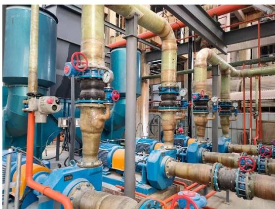
脱硫废水环保处理系统浓缩减量阶段示意图
