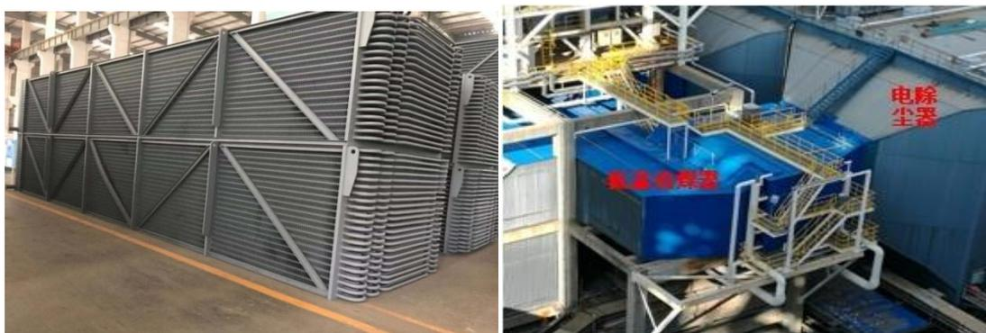
低温烟气余热深度回收系统的核心设备为烟气深度冷却器（也称“低温省煤器”），是一种采用冷却工质对烟气进行深度冷却并吸收余热的热能转换装置。该装置的创新之处在于：通过揭示烟气深度冷却过程中飞灰所含的碱性物质  $\text{SO}_3/\text{H}_2\text{SO}_4$  蒸汽和液滴的气液固三相凝并吸收脱除  $\text{SO}_3/\text{H}_2\text{SO}_4$  新机理，利用烟气中大量的碱性灰尘，在烟气降温过程中凝并、吸收、脱除酸性物质和灰尘，从而避免低温环境下酸性气体与水蒸汽凝结形成酸蒸汽。该装置的节能环保优势主要体现在以下几个方面：
