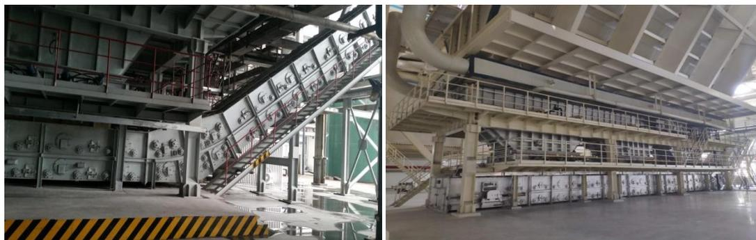
根据结构方式和原理，干式炉渣处理系统的核心设备分为网带式干渣机和鳞斗式干渣机两种类型，公司产品以鳞斗式干渣机为主。
