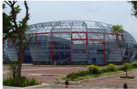
昆明新亚洲体育运动城 网球训练馆钢结构工程
