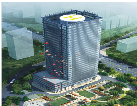
昆明爱尚苑高层钢结构工程
