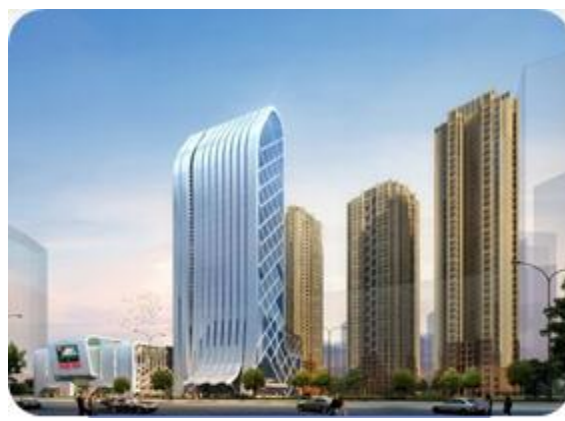
昆明云路中心超高层写字楼钢结构工程
