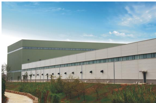
云南白药集团物流中心库房钢结构工程
