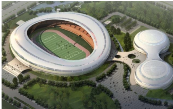
曲靖市体育馆 钢结构工程
