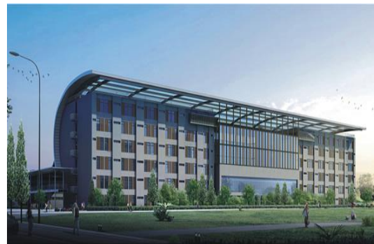
云南南天金融电子钢结构工程
