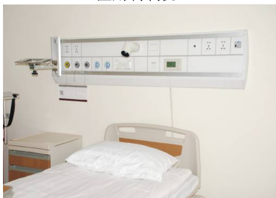
抢救室气体系统末端装置
